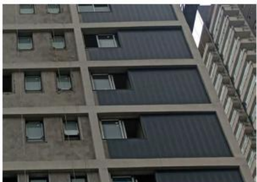
INSTALAÇÃO DO MINIWAVE FACHADA
