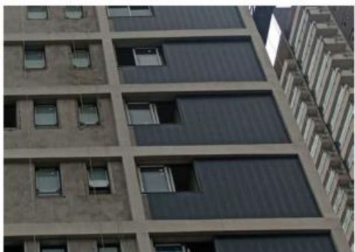
INSTALAÇÃO DO MINIWAVE FACHADA
