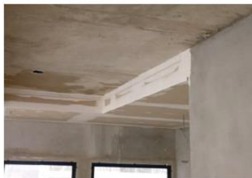
FORRO DE GESSO 10º PAVIMENTO
